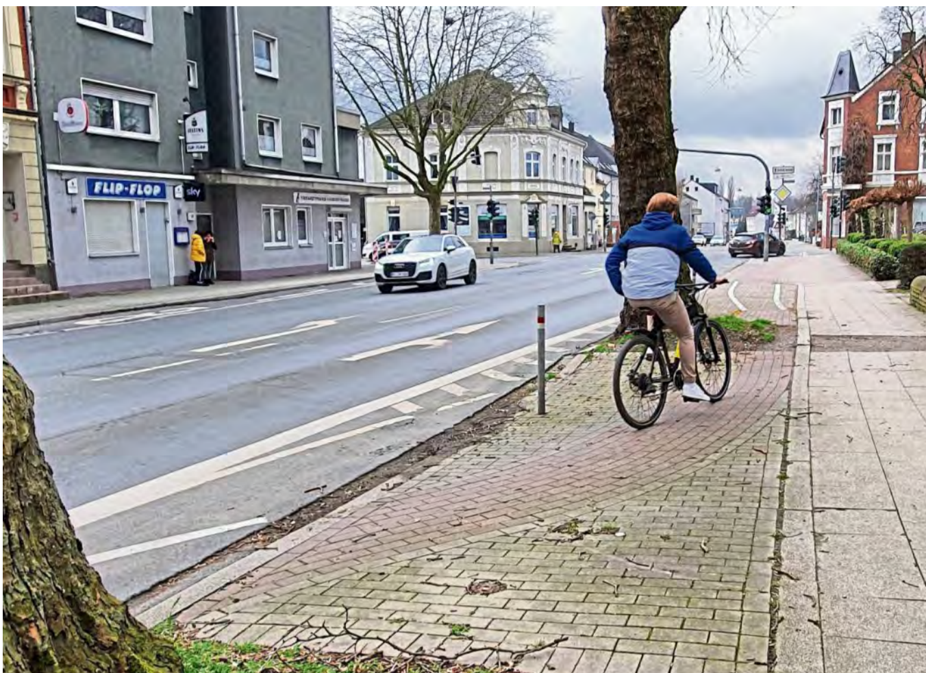
Die Kaiserstraße ist bei Radfahrern unbeliebt. Hier zum Beispiel, kurz vor der Kreuzung Josefstraße/Reitkamp, werden Radler direkt hinter einem dicken Baum von der Fahrbahn auf einen schmalen gepflasterten Weg gelenkt, der über eine holperige Baumscheibe führt. Diese ist zum Teil mit dicken Wurzeln gefüllt, zum Teil tief ausgespült.
